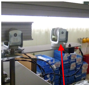
走行ユニットのランナーをレールに入れる
