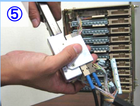
⑤ 加入者ケーブルと新規設備側のPATコネクタを勘合工具により接続します
