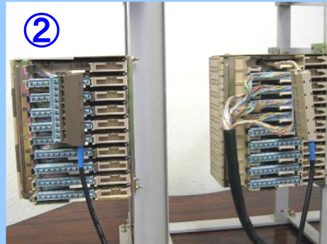
② マルチケーブルの残っている片方側を新規設備側のPATコネクタに接続します。
