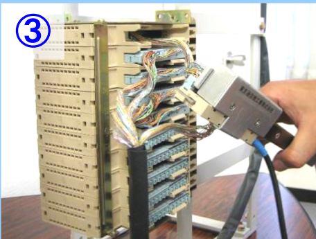
③ 既存設備側に接続されている加入者ケーブルのPATコネクタを分離工具を使用して取り外します。
