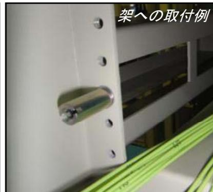
リストバンド用接地端子のない装置・架に設け、リストバンドのプラグを直接差す事が可能です
